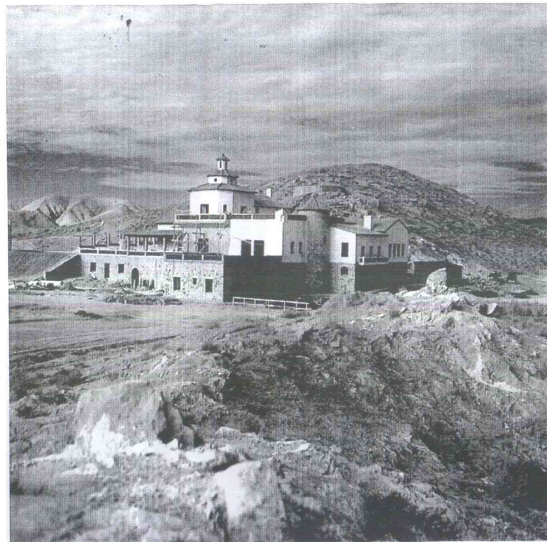
Construcción de la Casa Club del Club Campestre Lagunero
