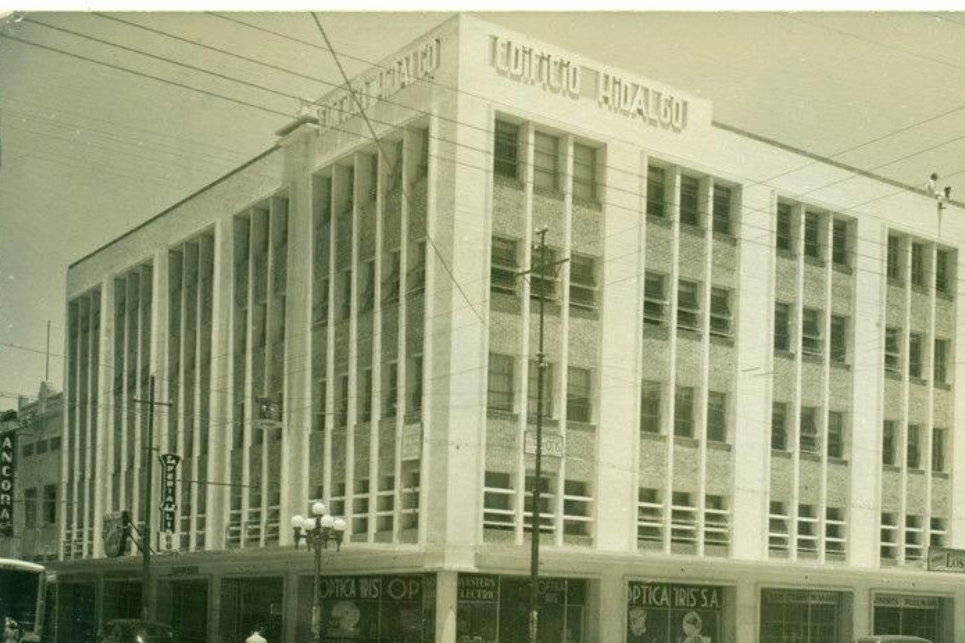
Av. Hidalgo y Calle Treviño (Edificio Hidalgo) 1960
