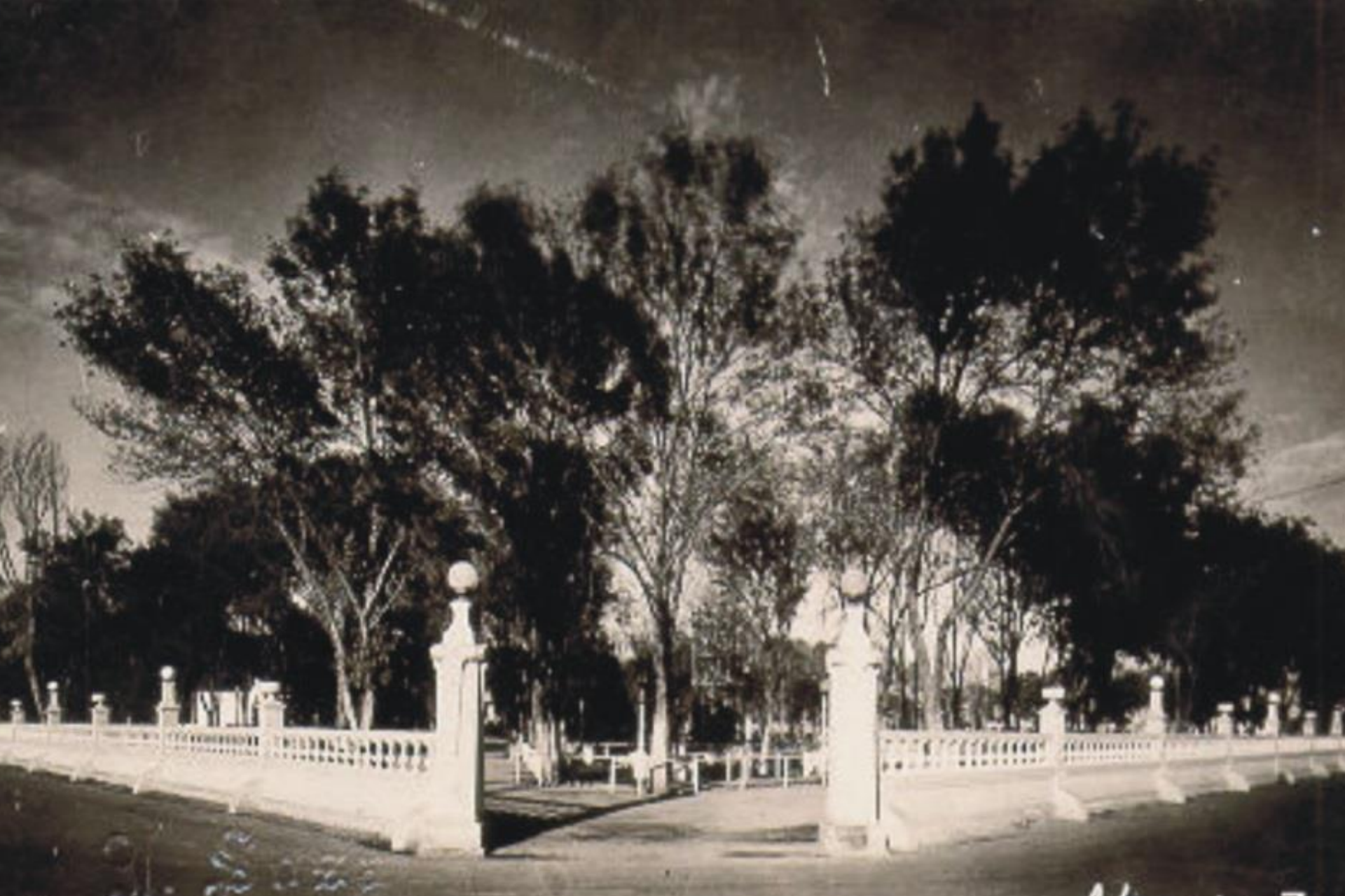
Av. Juárez y Calle García Carrillo (Alameda Zaragoza) 1930
