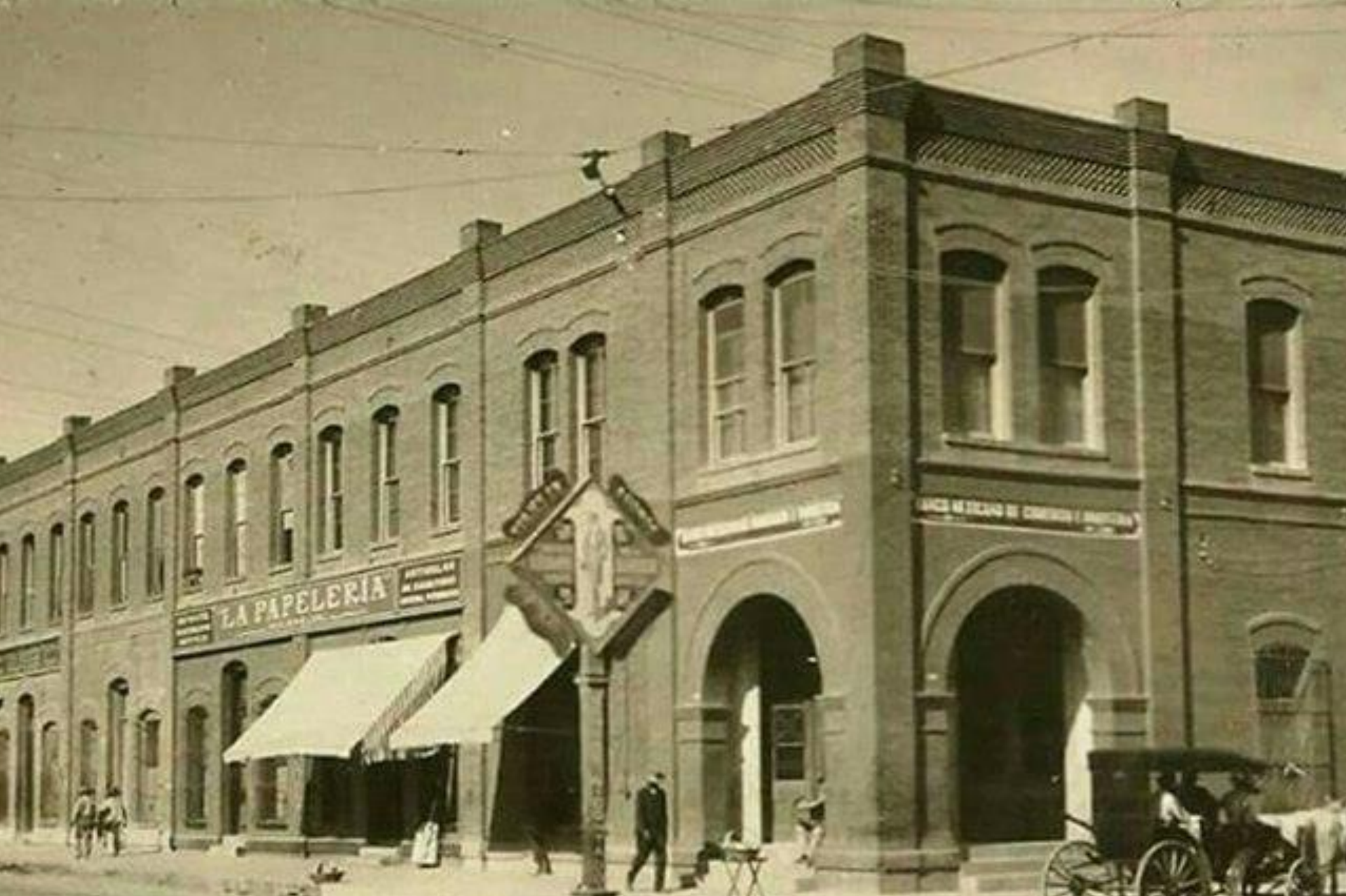
Av. Juárez y Calle Zaragoza ( Antiguo edificio de la Papelería) 1915
