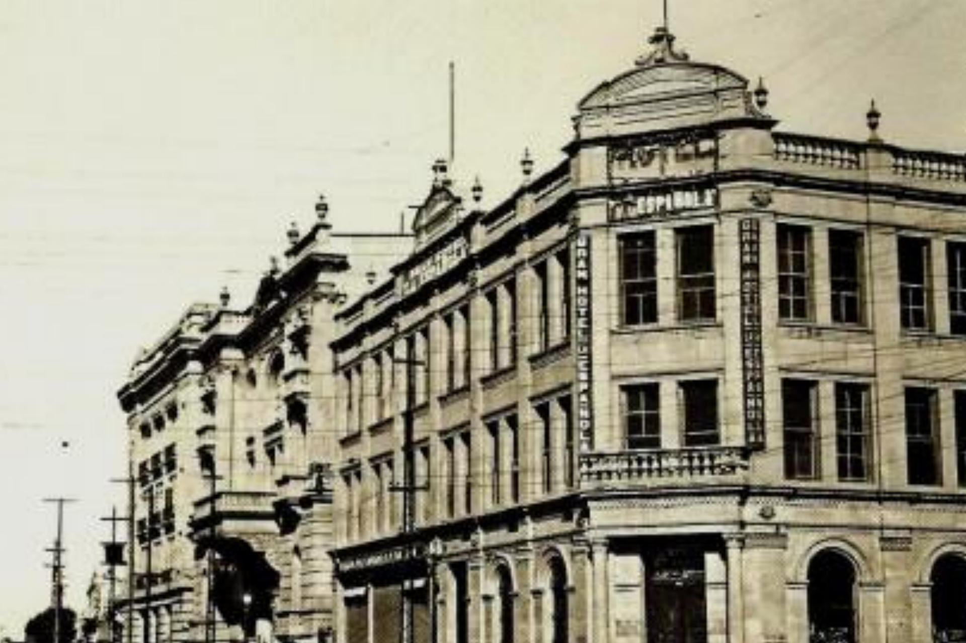
Av. Juárez y Calle Valdés Carillo (Banco Chino) 1920
