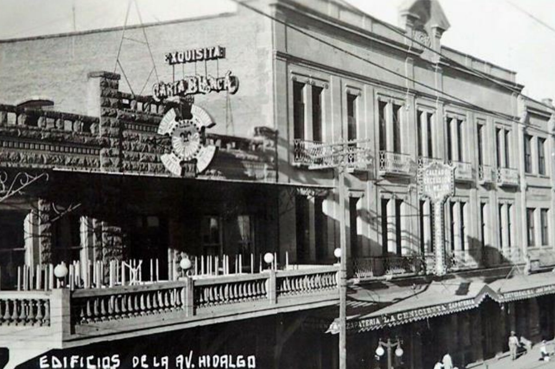
Av. Hidalgo entre Calle Juan A. De La Fuente y Calle Zaragoza (1930)
