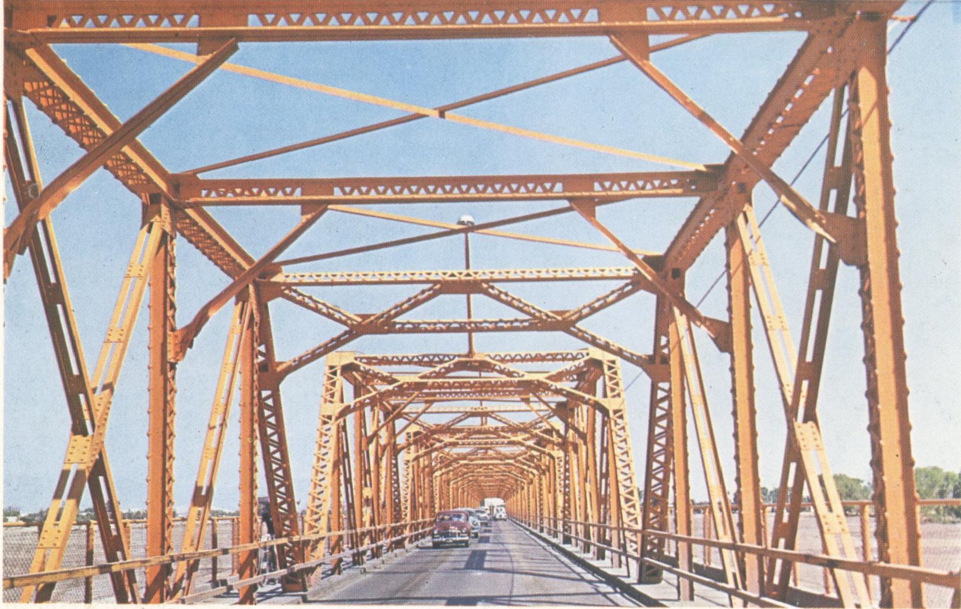
PUENTE SOBRE EL RIO NAZAS.
