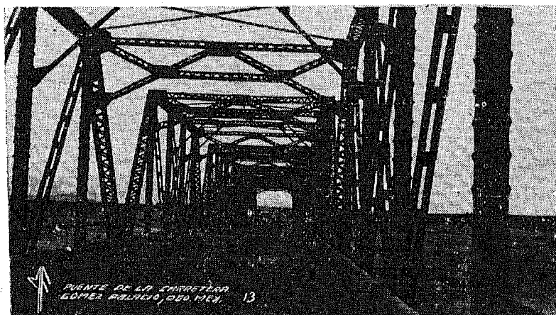
Puente para automóviles sobre el Río Nazas.
