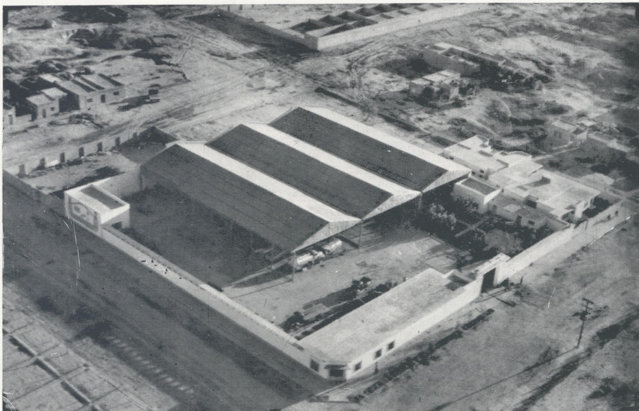
La Paileria del Sr. José Herrera Mora que fabrica Tanques de enormes dimensiones.
